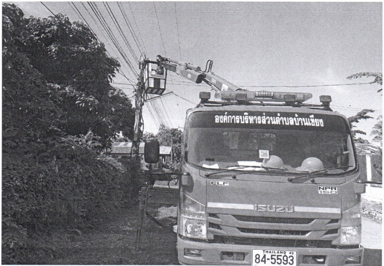
ภาพประกอบการซ่อมแซมไฟฟ้าในพื้นที่ อบต.บ้านเชียง
